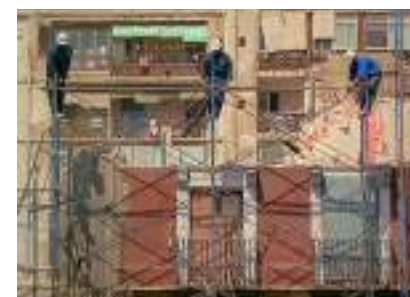
16 – Demolições no bairro e nas ruas (de 32min 37s a 33min 25s)
