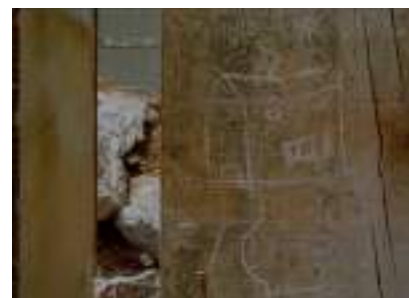
42 – Desmantelamento do muro de madeira com as pinturas das crianças. Demolições no bairro (de 1h 17min 11s a 1h 17min 46s)
