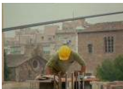
17 – Trabalhos dos carpinteiros de cofragem (de 33min 25s a 33min 54s)
