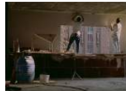
59 – Trabalhos na obra: reboco da parede, ensaio, acabamento de fachadas (de 1h 49min 29s a 1h 50min 25s)
