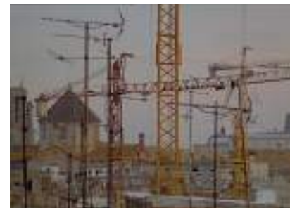
47 – Gruas e terraço da obra (de 1h 26min 22s a 1h 26min 37s)
