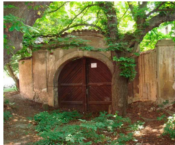
Entrada da casa de Trnka em Košíře, Praga
